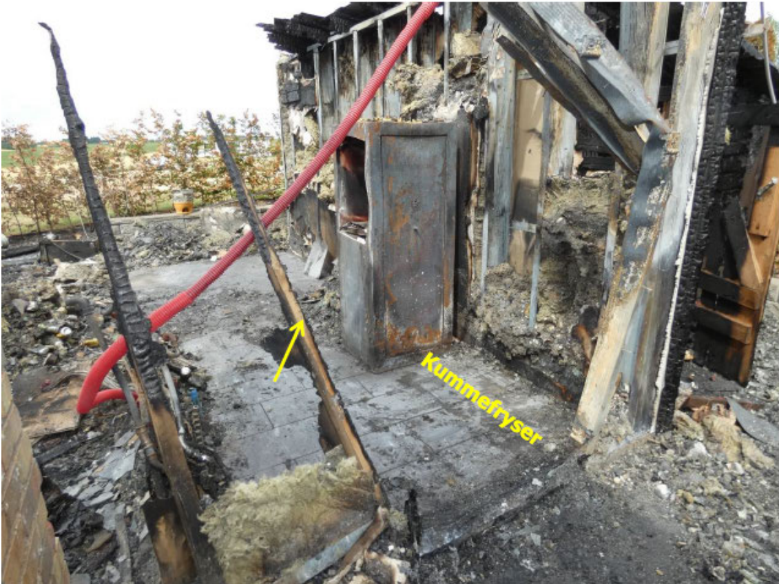
Trærigler til venstre for den østvendte dør i skuret er kraftigst forkullet på den side, der vender indad og riglen tættest kummeffryseren er kraftigst brandskadet (pil).
